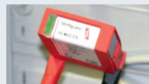
Bezpośrednie podłączenie modułu ochronnego DEHNGuard
